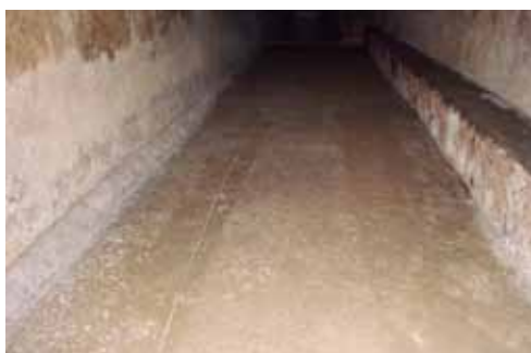
fig.12 A sinistra muretto costruito dall'ex proprietario, ora rimosso
