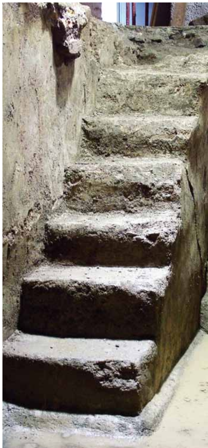
fig. 4 Scala originaria della cisterna riutilizzata per l'accesso al mitreo
